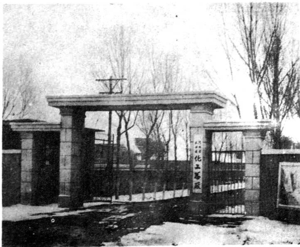
武强县化工总厂始建于一九八四年，该厂有数种化工产品被命名为省级名牌产品。图为武强县化工总厂。
