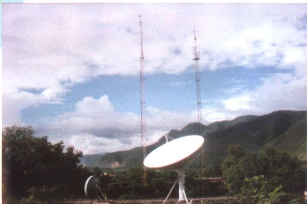
1986 年 7 月建成投入使用的第一座地面 卫星电视收转设备(发射设备功率为 100W)
