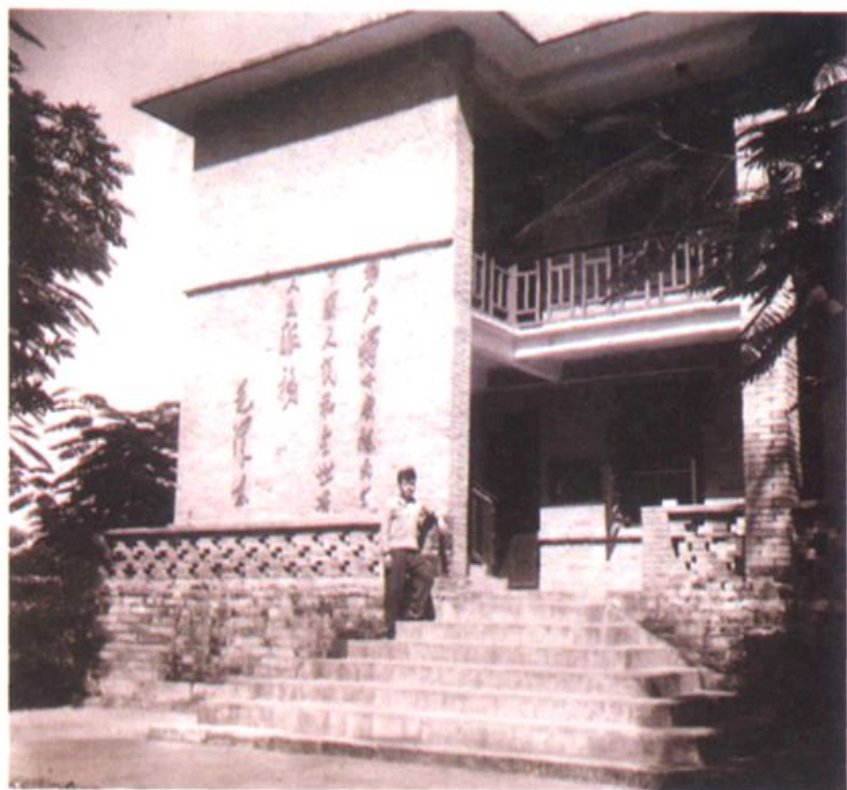
1966 年改建后的县广播站机房、办公室(1966 年以前,广播站设在尊经阁内)
