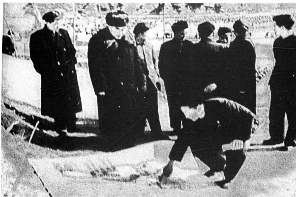
朱德在水利工地听技术人员汇报(1958年2月19日)
