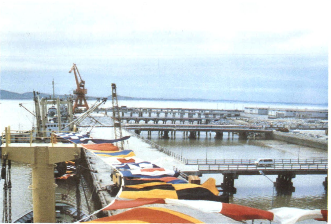
泉州后渚港3000吨级码头
