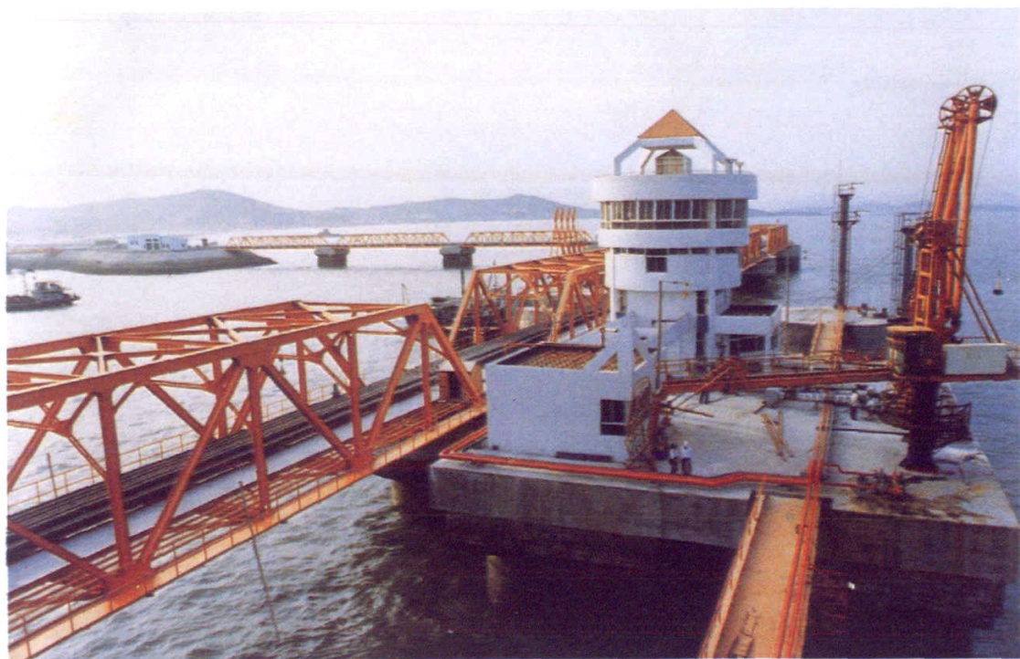
泉州肖厝港10万吨级码头
