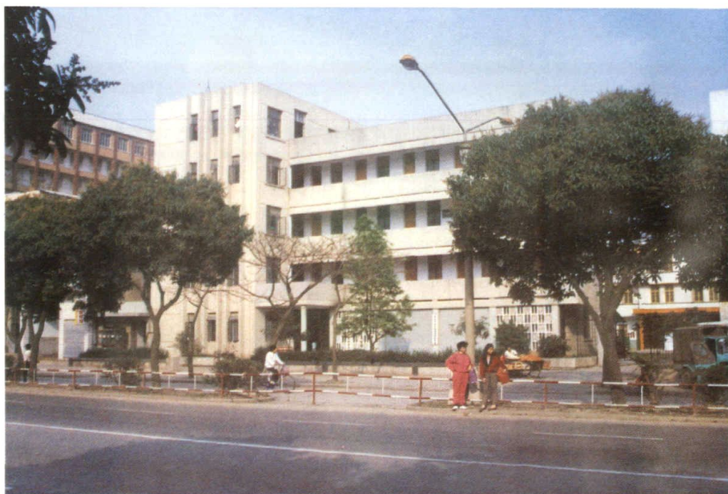
福建省泉州市对外贸易公司大楼
