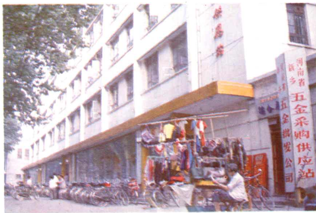
新乡五金站办公楼
