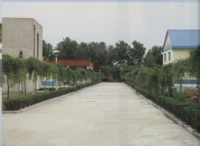
污水处理厂厂区
