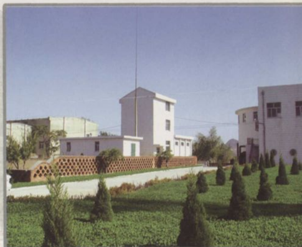
饮马池水厂水处理车间
