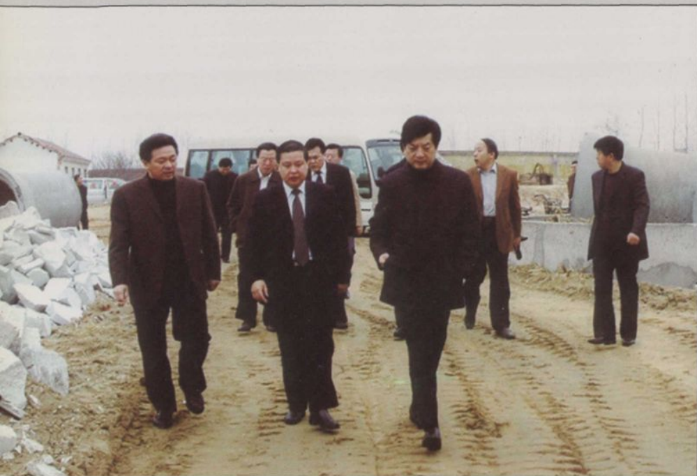
2006年11月，中共烟台市委书记孙永春在莱州市市长杨洪旭陪同下视察小沽河调水工程施工现场
