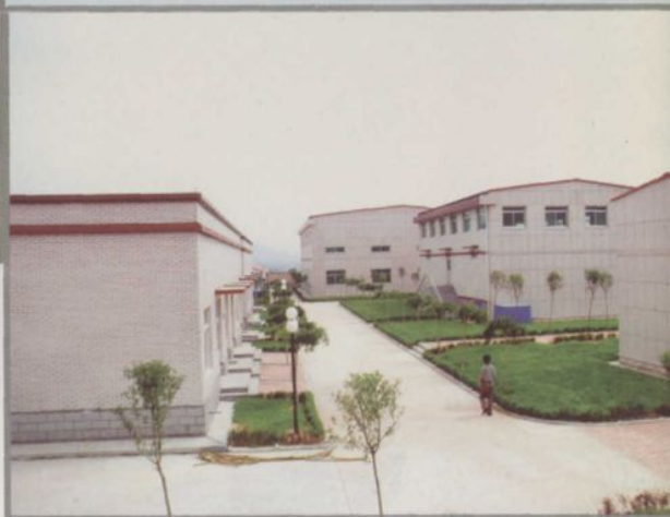
云峰水厂制水厂区
