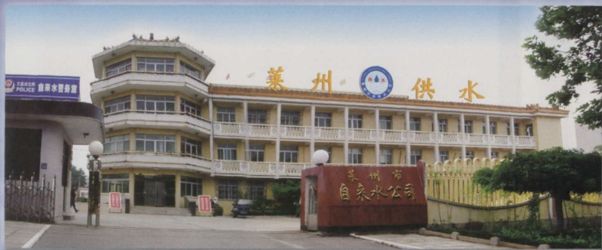
公司办公楼全景
