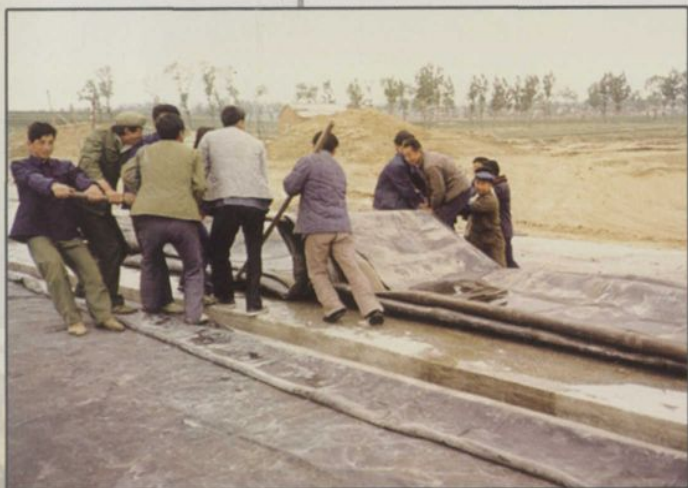
小沽河橡胶坝工程坝袋安装
