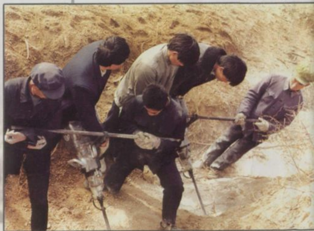
复线一期工程管沟开挖
