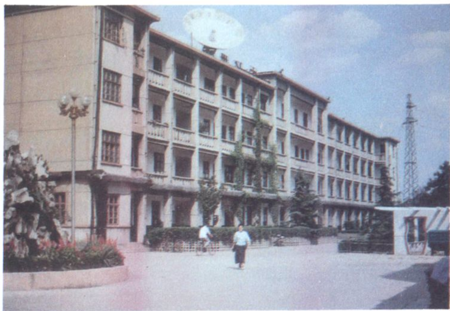
机 关 办 公 大 楼
