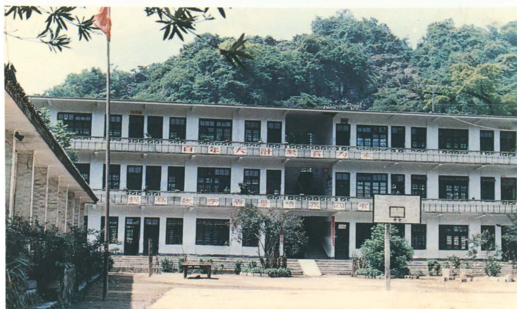
②③ 更新中心校 教学楼
