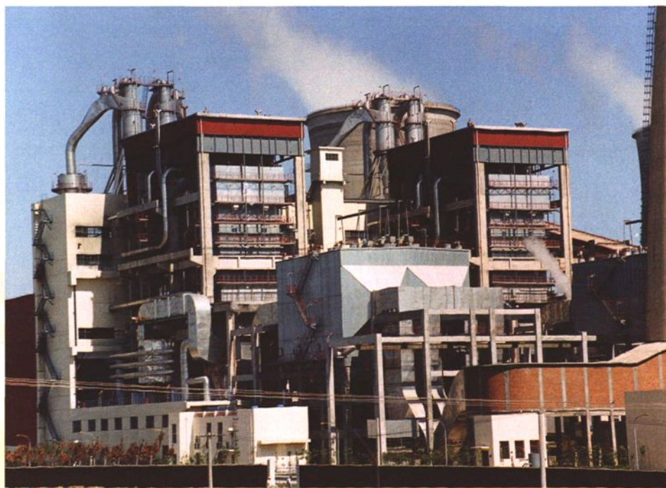
蒲山电厂 #1、#2 锅炉
