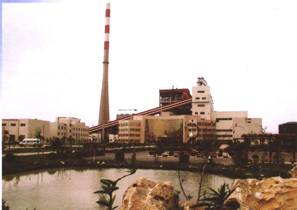
风景如画的电厂厂区
