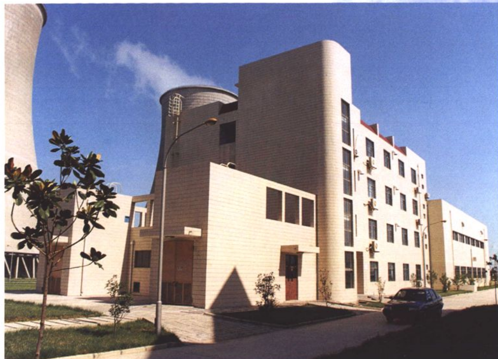
蒲山电厂化学楼
