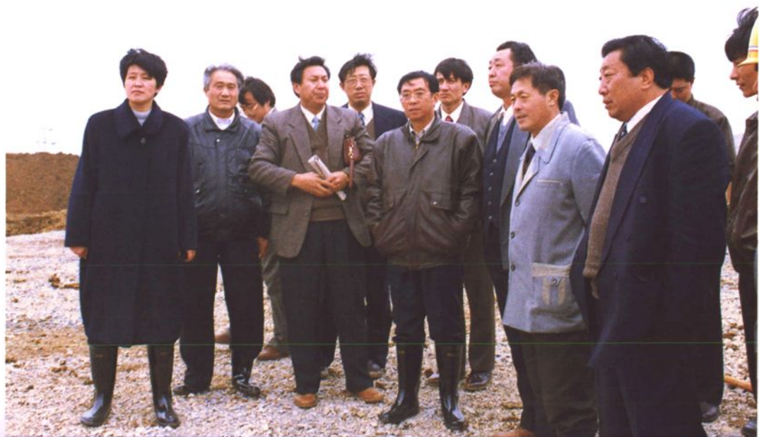
1997年1月9日，省电力局副局长吴华斌(左四)视察电厂工地
