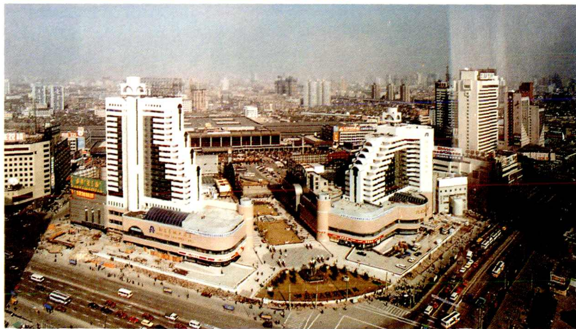
● 上海铁路新客站地区
