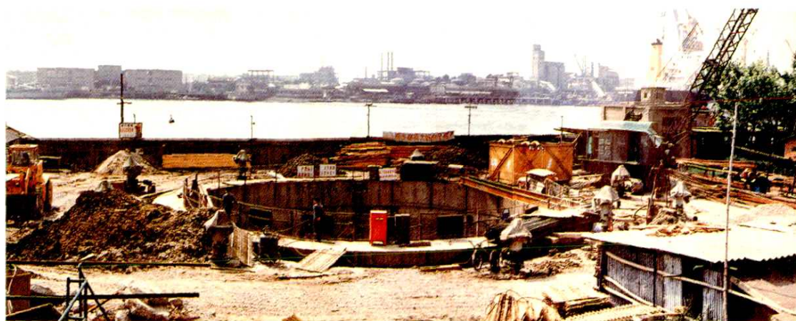
● 黄浦江上游引水工程南市水厂竖井过江隧道
