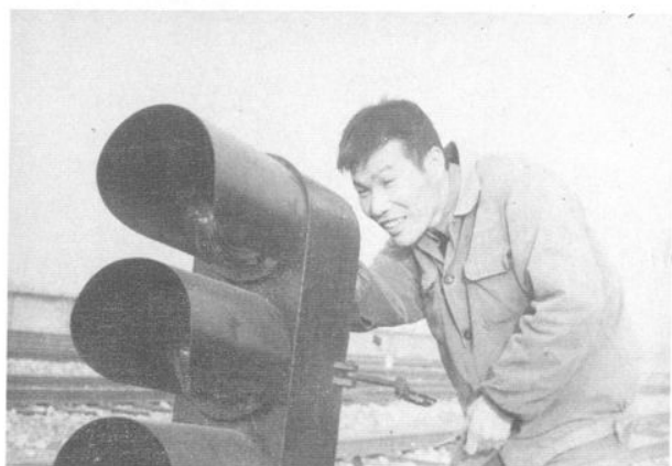
检修铁路信号
