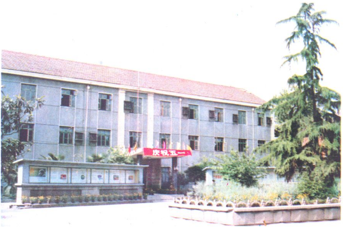
运输部机关办公楼
