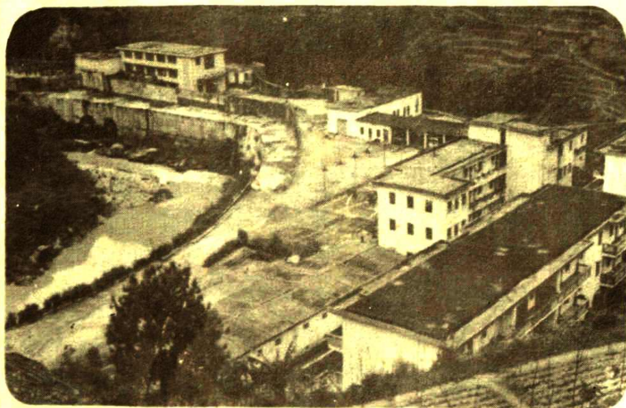
装机容量1.2万千瓦的张公龙水电站
