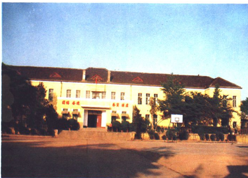
学校旧教学楼（于1992年11月拆除）
