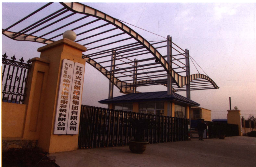
江苏火花钢结构集团有限公司
