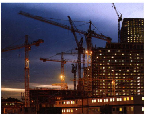
徐矿城市建设现场夜景
