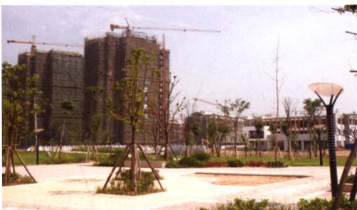
徐矿城市建设现场
