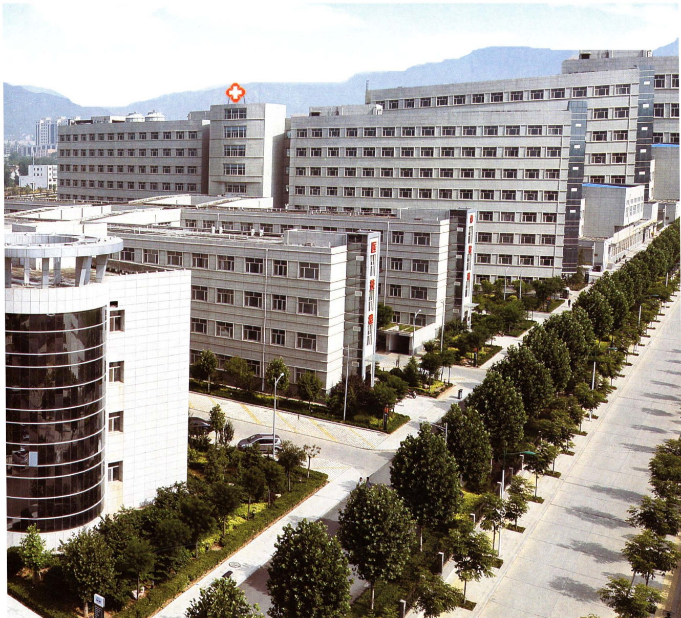
垣曲县人民医院全景
