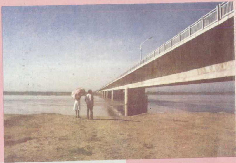
包西公路黄河大桥
