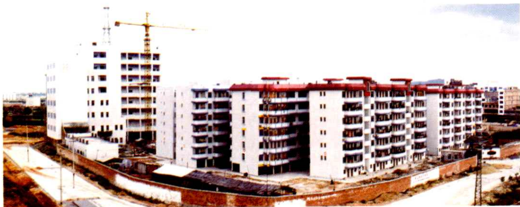
在建的城北电信楼和邮电宿舍楼
