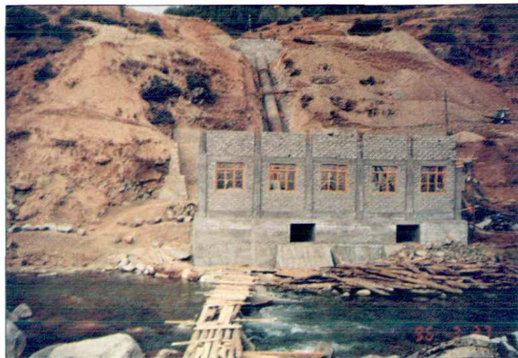
►正在修建中的拉波乡夏尼电站， 装机容量 2 \times 200\text{kW}
