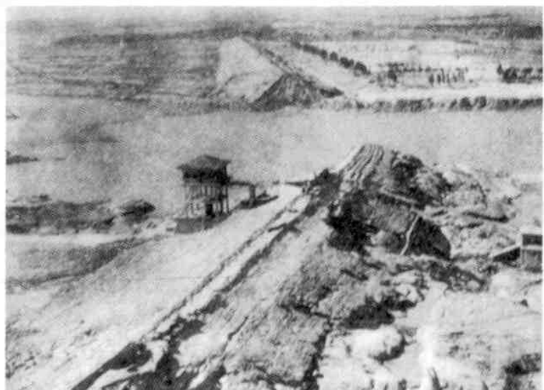
板桥水库大坝决口处
