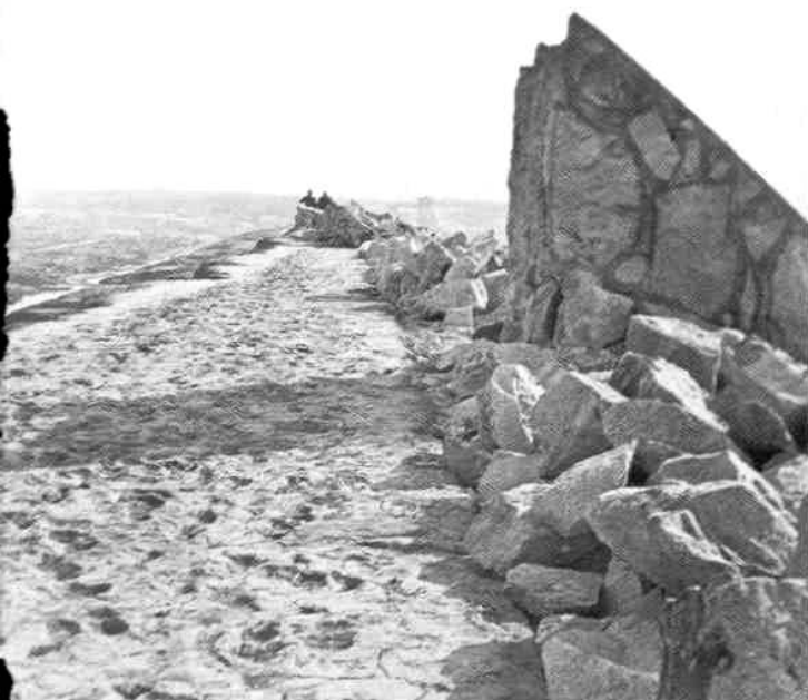
冲毁的板桥水库坝顶和防浪墙
