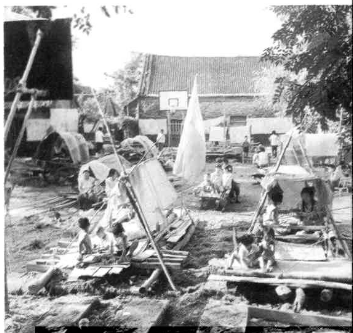
汝南县县人民医院院内准备避难的木筏
