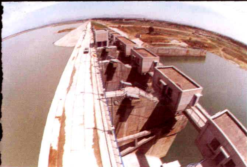
复建后的板桥水库雄姿
