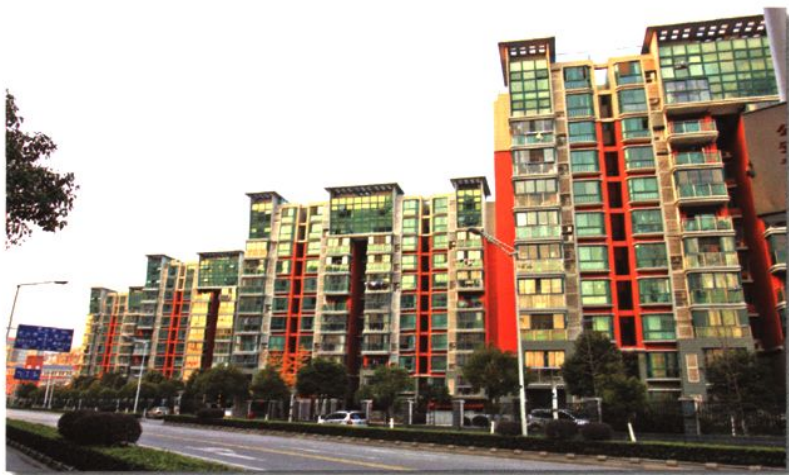
2006 年竣工的兴元嘉园小区
