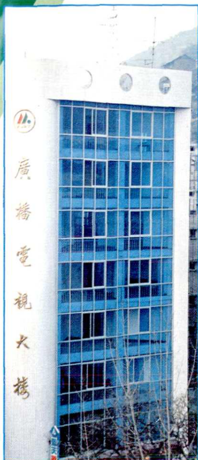
广播电视大楼
