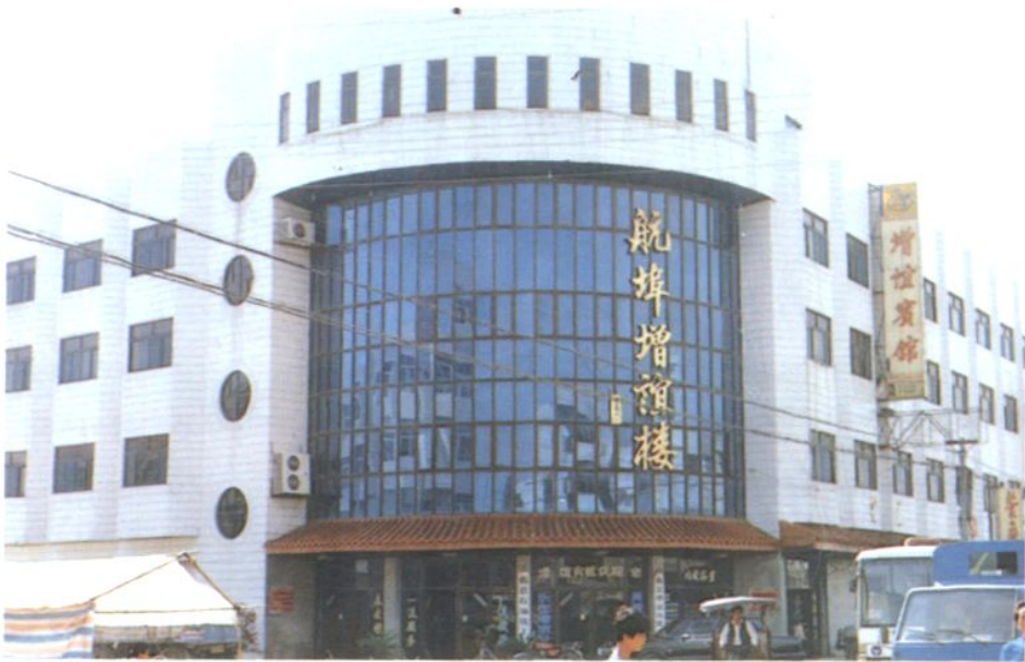
衢县航埠增源楼(私营企业)门景
