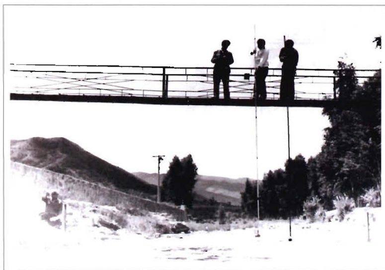
► 崇礼水文站钢桁架测桥
