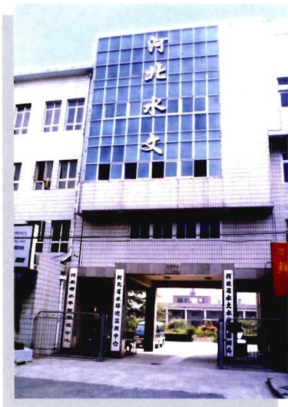
▲ 河北省水文水资源勘测局办公楼
