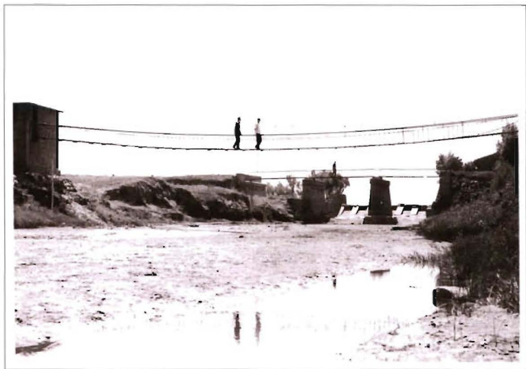
▶ 张北水文站悬索测桥
