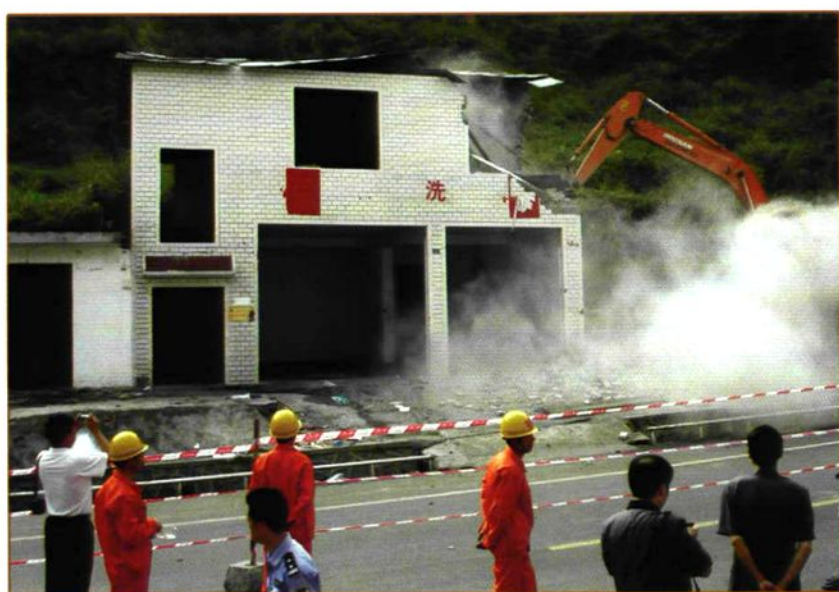
拆除违法建筑物
