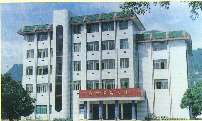
▲ 1995年12月竣工的教学实验大楼。该大楼总建筑面积2800平方米，造价140万元。
