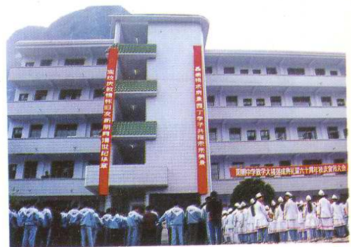
▲1997年11月竣工的教学大楼,建筑面积1974平方米,造价72万元。
