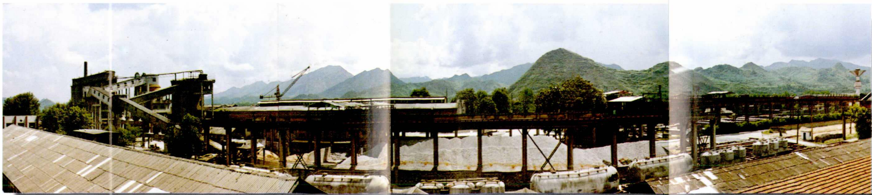
轨枕生产车间一角
