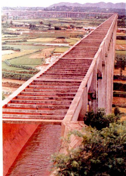
峡口水库西干渠渡槽
