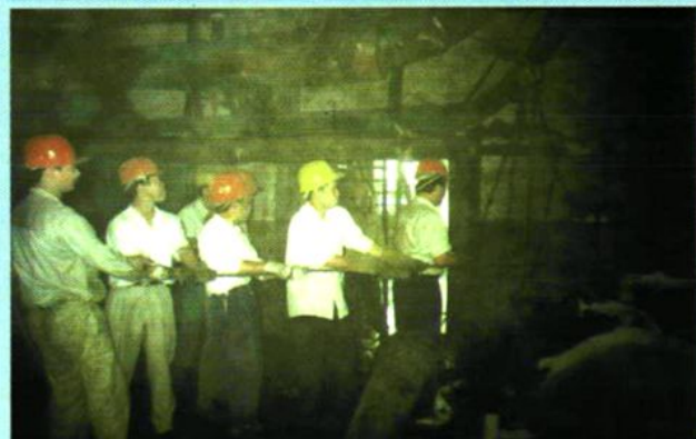
拆除机炉设备
