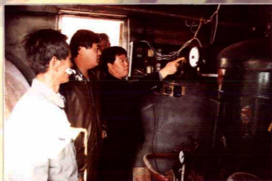
大高村在安装自来水
