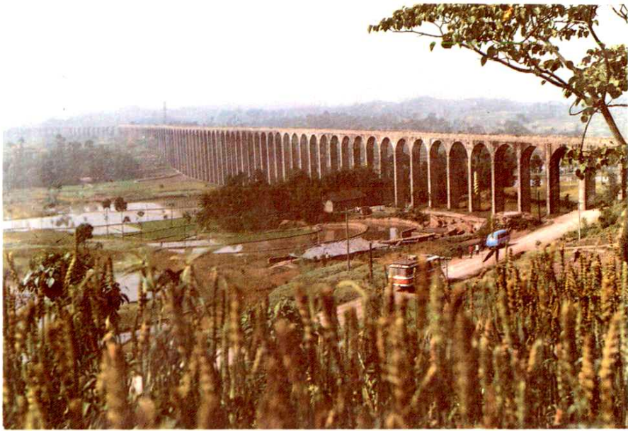
圖爲雙桂石拱渡槽，全長一千三百四十米，寬二點一米，最高點距地面三十米，一百四十三孔。工程雄偉，建築精細，爲我縣渡槽之首。
