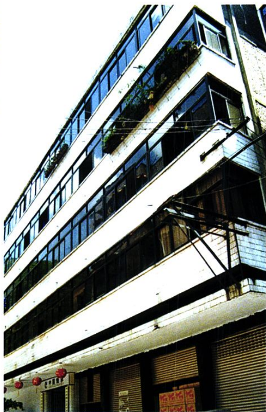
屏山县烟草专卖局、屏山县烟草公司办公楼。
