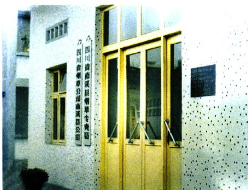
南溪县烟草专卖局、南溪县烟草公司办公楼
