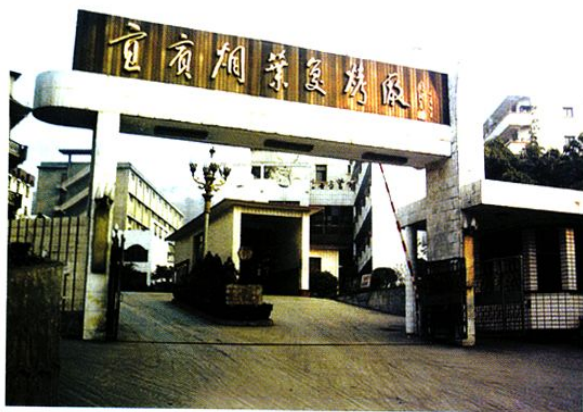
1990年8月竣工的宜宾烟叶复烤厂厂貌
