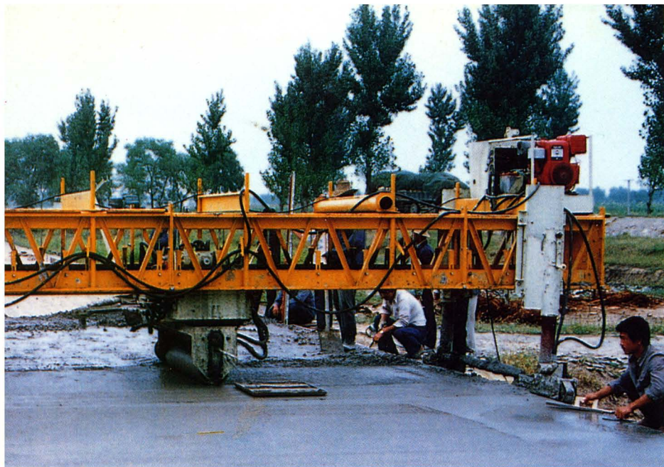
廊坊地区公路处工程一队 在溢流洼施工
