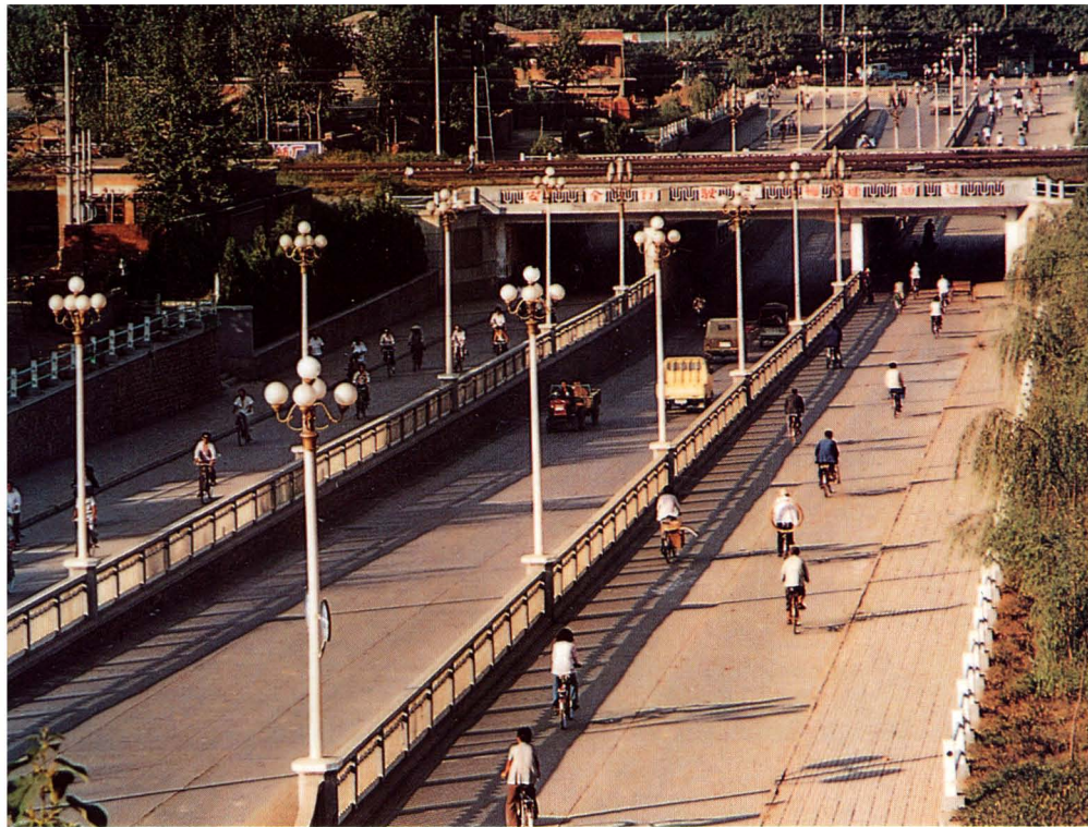
廊坊市内立交桥
