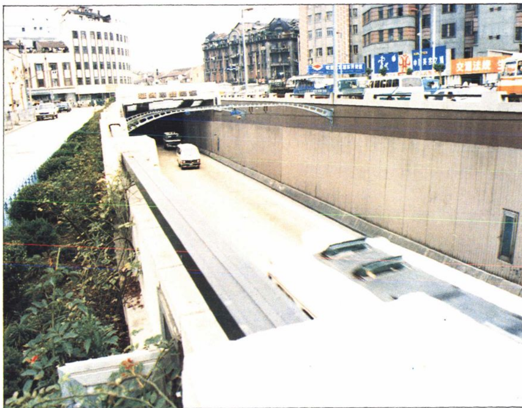
延安东路隧道入口
