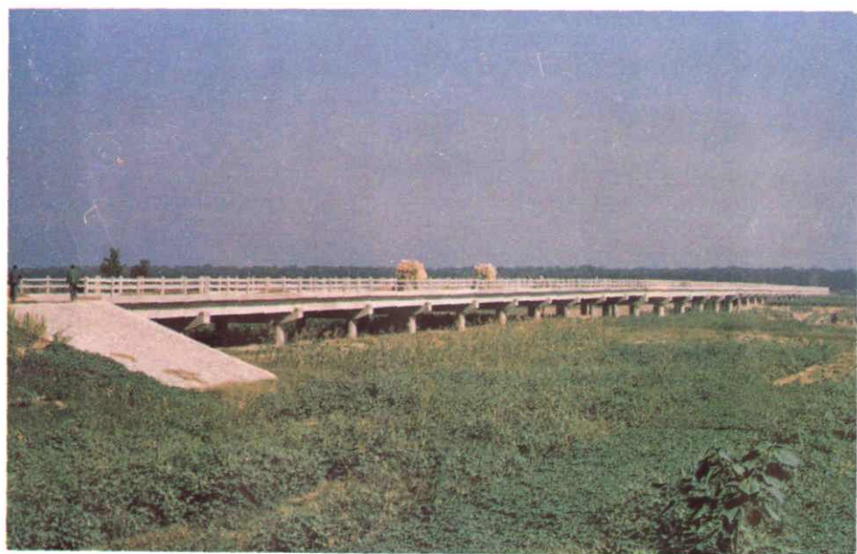
◀ 卫河苏堤大桥
