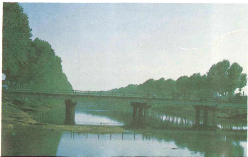
◀ 马颊河城关大桥
