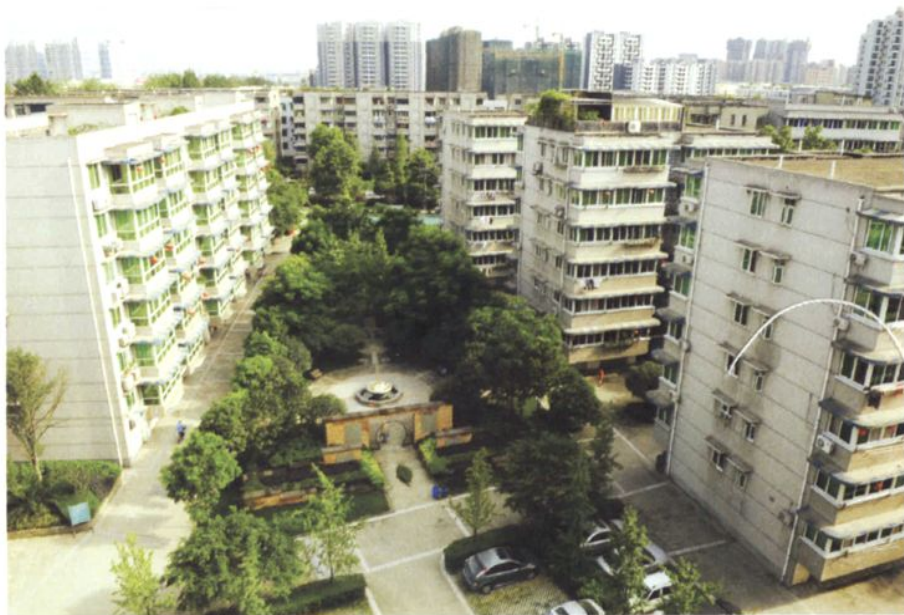
▲ 21 区调队华阳队部生活区的宿舍楼。范晓摄于2009年8月
