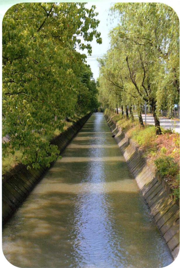
村中心支渠(2017年摄)
