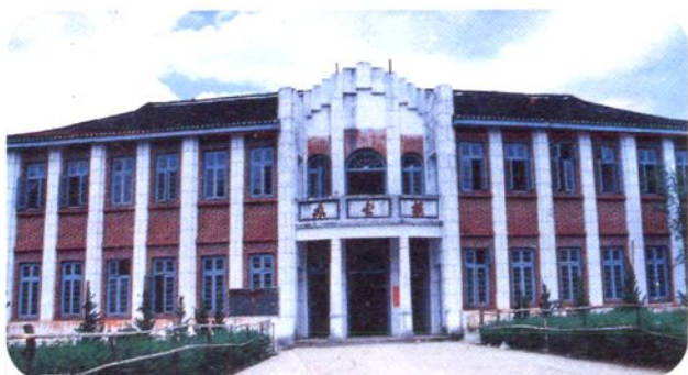
永州市一中办公大楼
