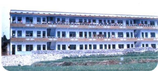
冷水滩市普利桥区中学教学楼
