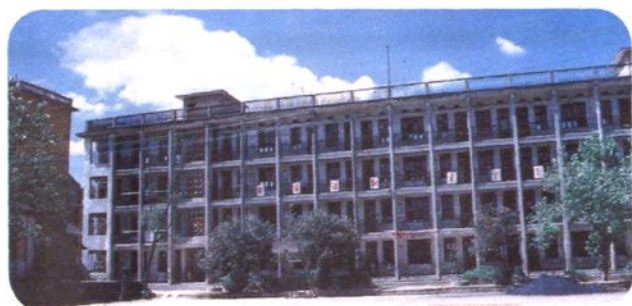
永州市第一小学教学楼
