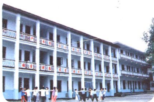
冷水滩市第三小学教学楼
