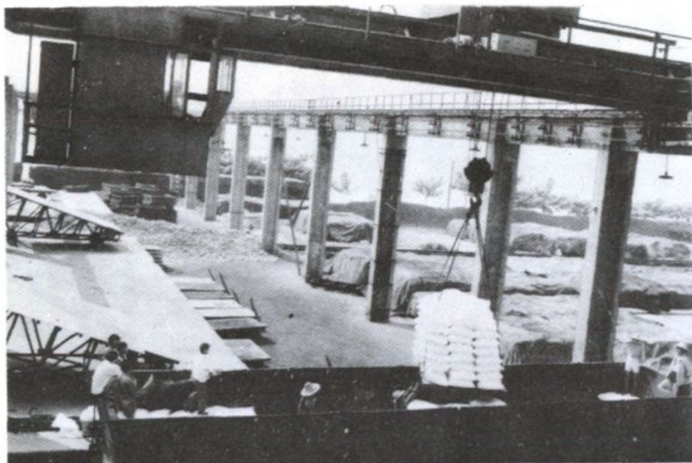
↑ 蓝家沱港埠公司桥吊装尿素
