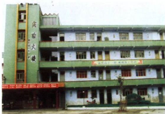
回澜职业中学实验大楼
