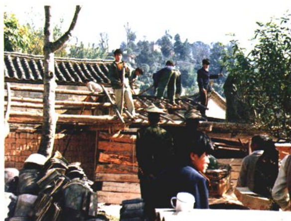
公、检、法和土地管理部门依法查处违法占地，强行拆除违法建筑
