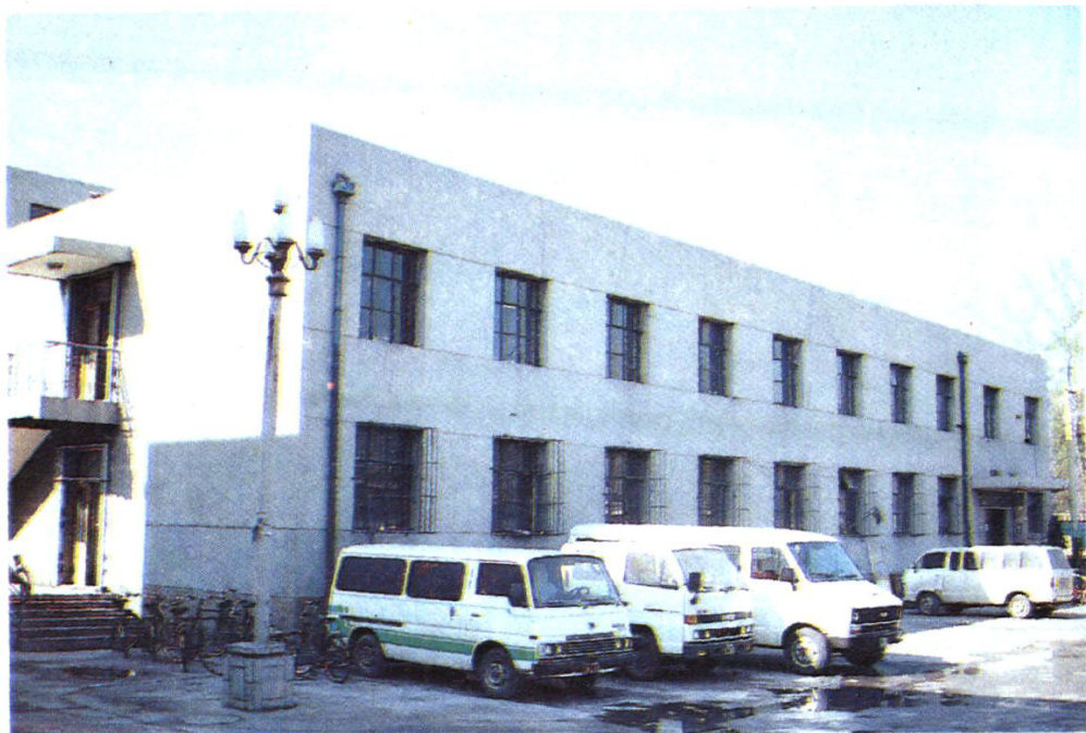
中国人民建设银行唐山地区中心支行办公楼 (地址:唐山市华岩路,1983年建成)
