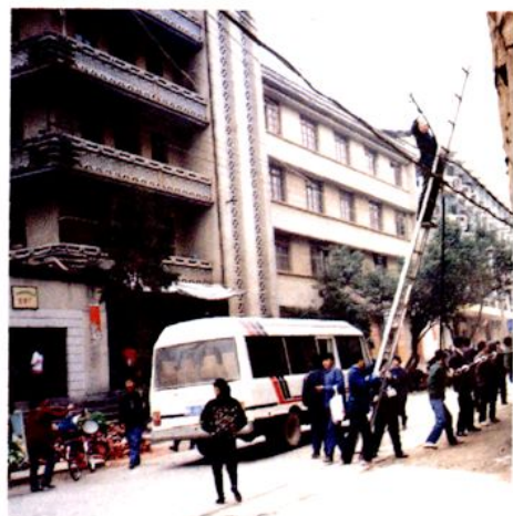
架设通信电缆
