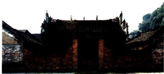
民国时期，借用大竹村曹家祠堂作乡村电话交换机房
