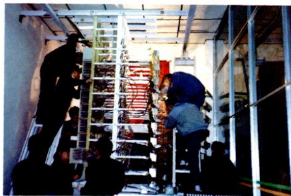
为程控电话开通工程技术人员在紧张割接
