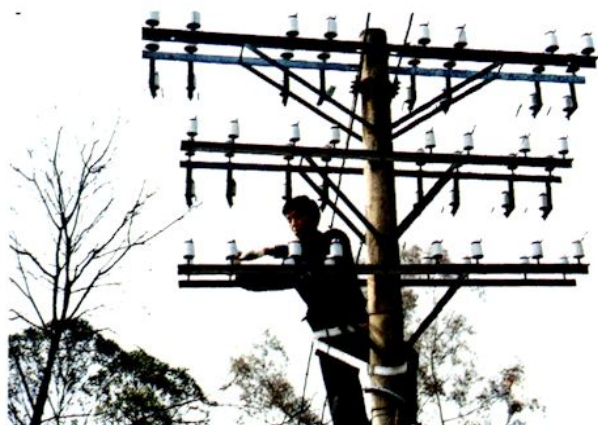
机线员精心维护线路
