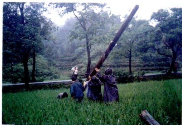
灾后机线员抢修通信线路
