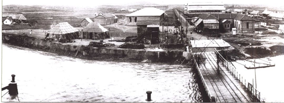
建设中的永利化学工业公司南京硫酸铵厂
