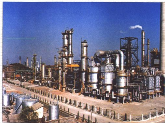
金陵石化公司炼油厂 80 万吨 / 年加氢裂化装置 (1987 年摄)
