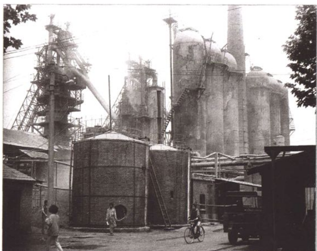
南京西善桥钢铁厂 1971 年建成的 2 座 100 立方米高炉(1973 年摄)
