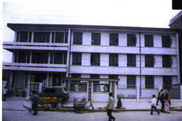
财政局办公楼全景
