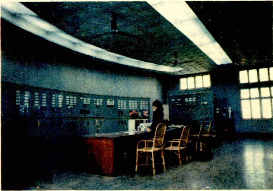
宝庆22万伏变电站值班室
