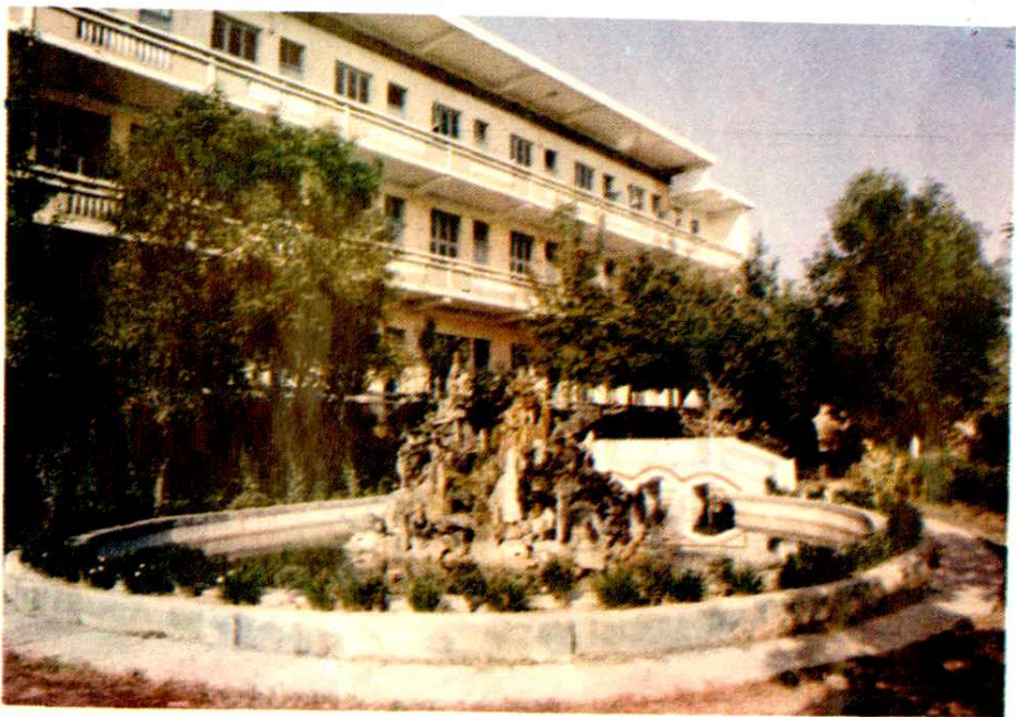
新邵电力局的喷水池
