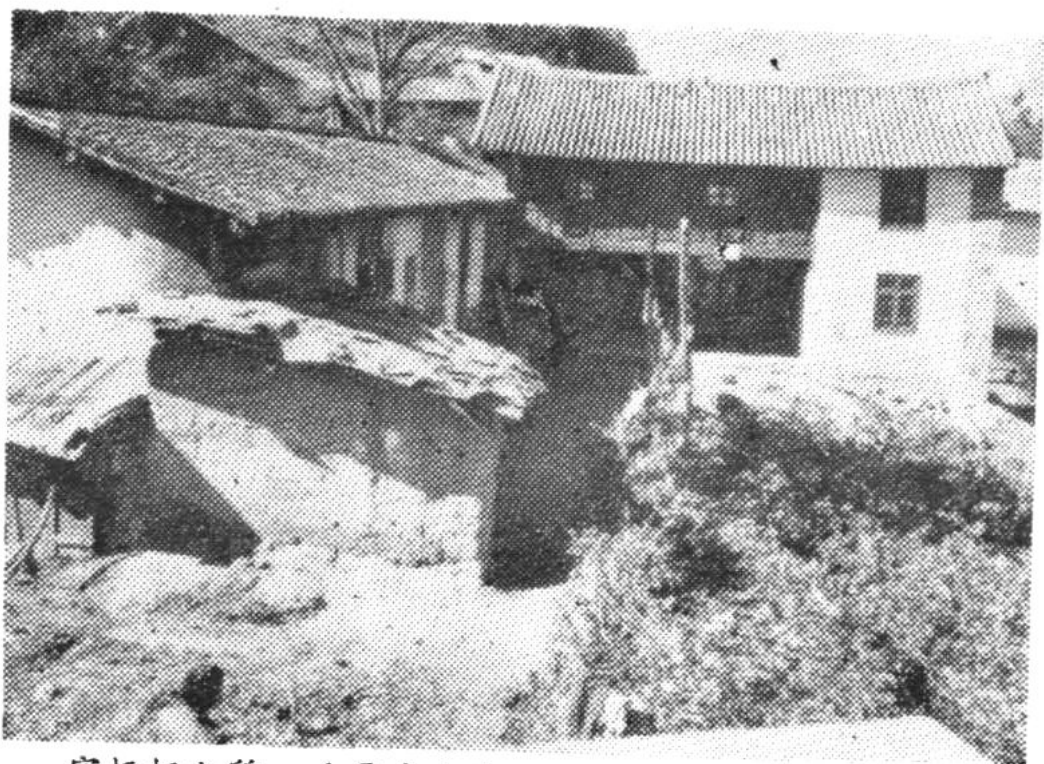
富恒邮电所，（平房建于1972年，楼房建于1981年）
