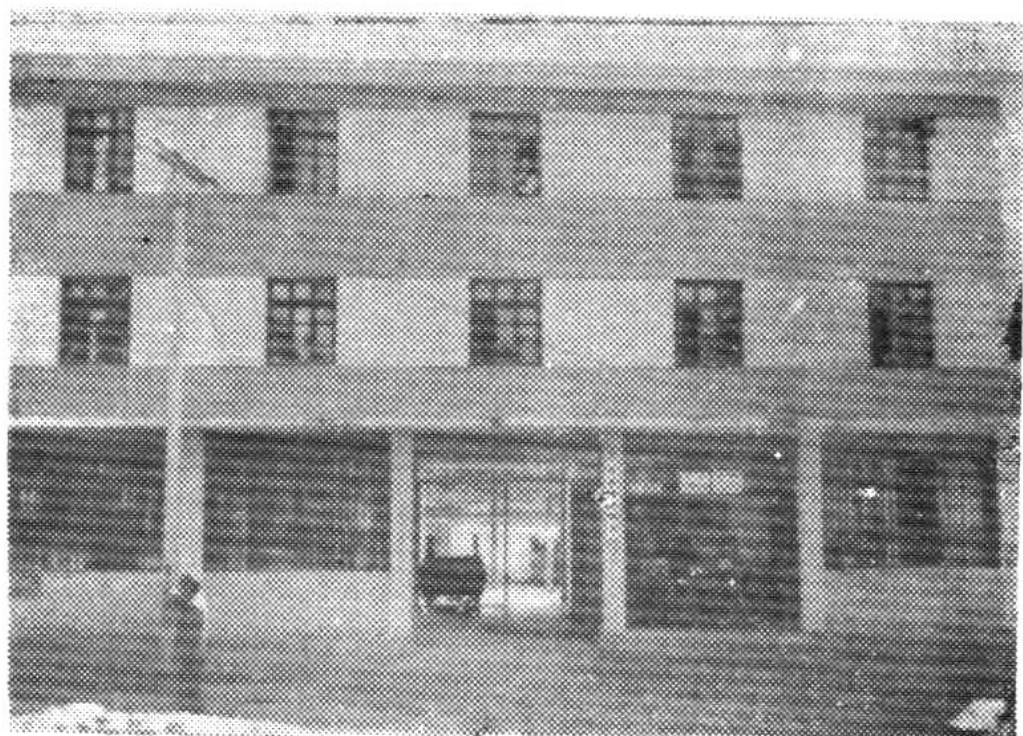
1988年建成的平坡邮电支局主房。
