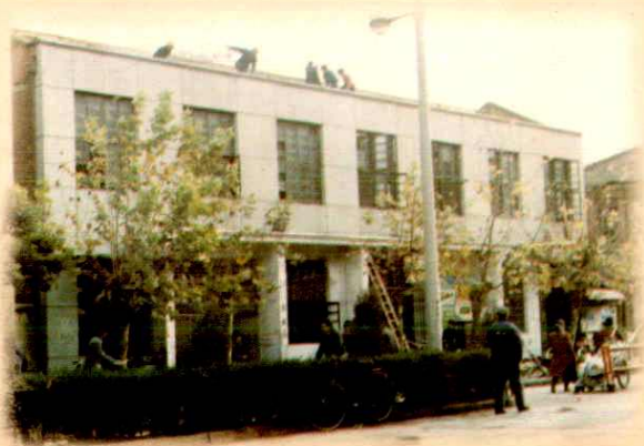
图为原孝感市邮电局电信营业室拆迁现场。
