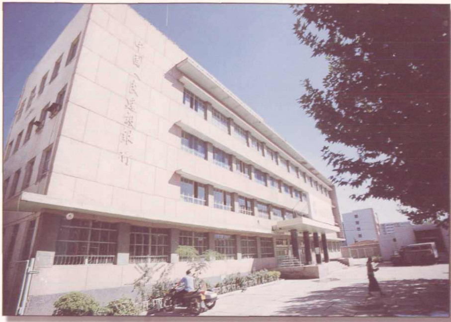
中国人民建设银行 阿克苏地区中心支行办 公楼外景
