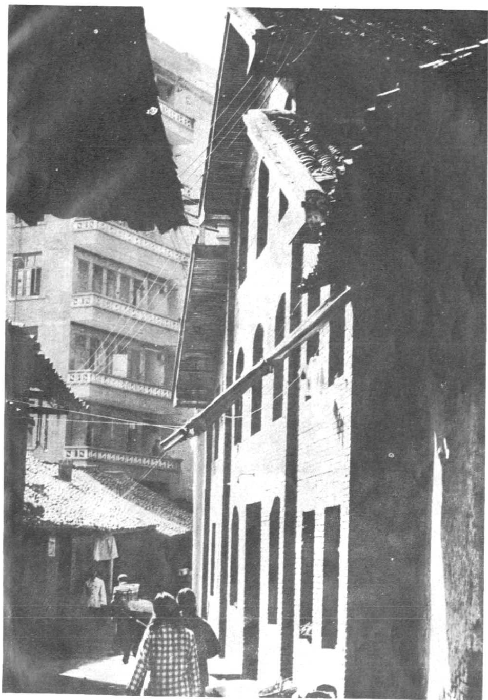
县制药厂旧址（何家祠堂）
