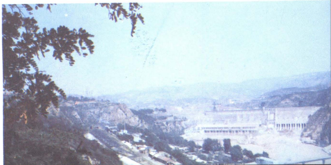
黄河三门峡水利枢纽工程
